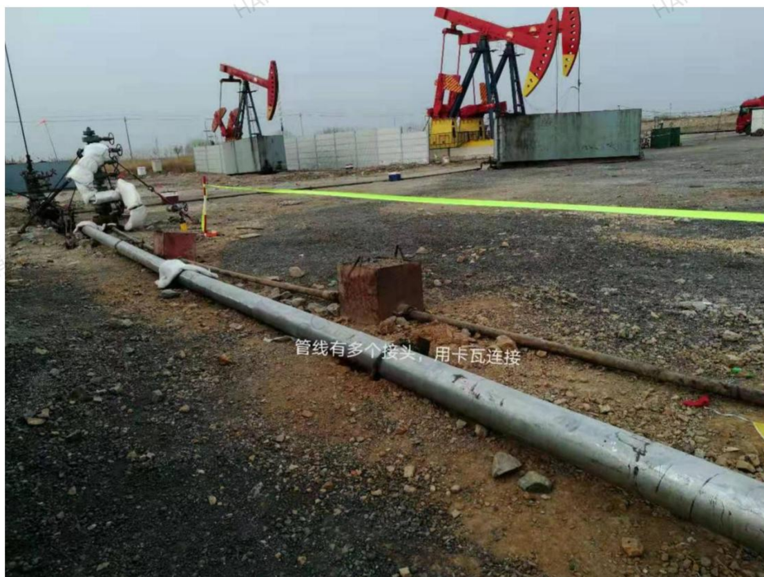
图一：现场管线采用卡瓦连接
