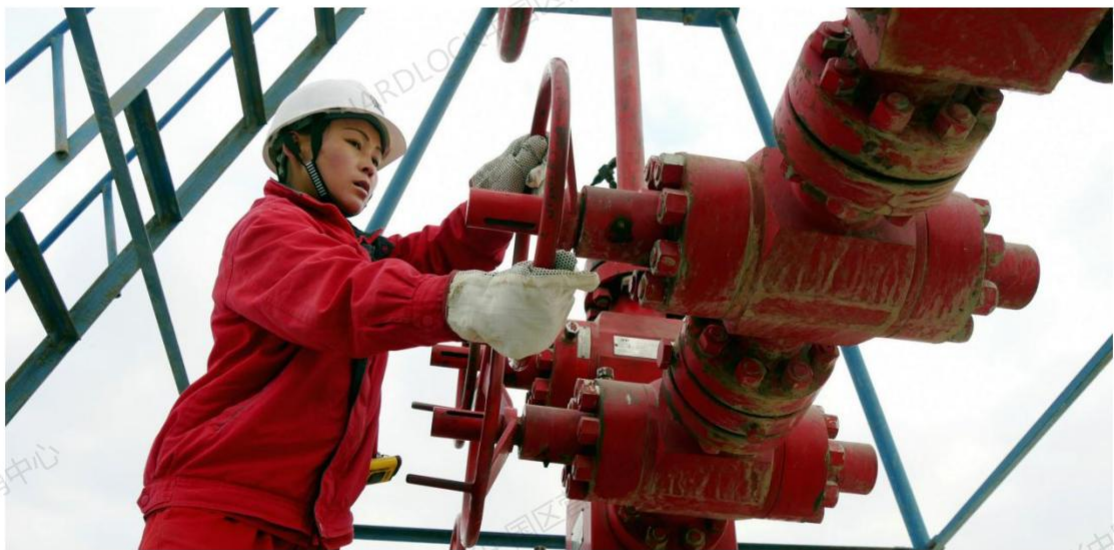
图三：现场管线阀门及法兰连接部位
